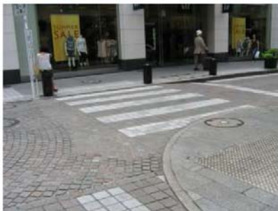
횡단보도 턱 낮추기 (일본 요코하마 모도마치)
